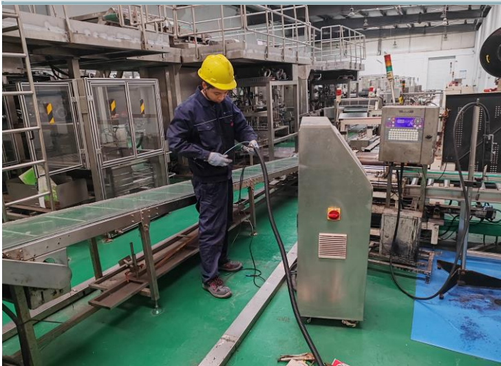
近日，随着包装盐车间的持续生产，王以知发现机械手传送带会因车间设备摆放位置导致员工处理堵包等问题时会有诸多不便，从而影响生产效率。于是王以知利用安全检查停机间隙，加班加点对设备进行移位工作。设备移位完成后，员工处理堵包等问题时的效率显著提升。（李竹菴）
